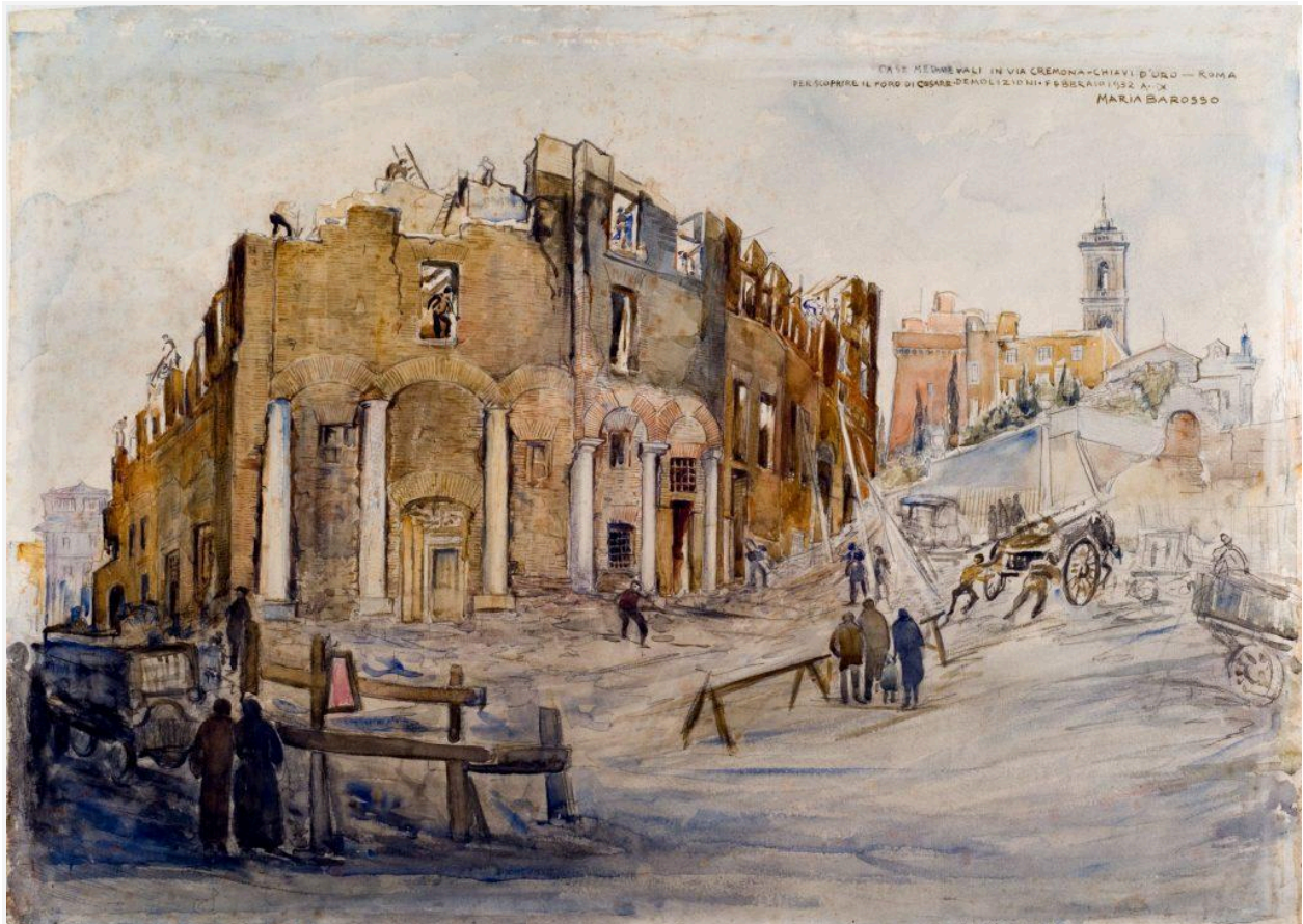
Fig. 21. Maria Barosso (1879-1960), Demolition of medieval houses between Via Cremona and Via delle Chiavi d'Oro, 1932. Museo di Roma-Gabinetto delle Stampe, MR 2491.
